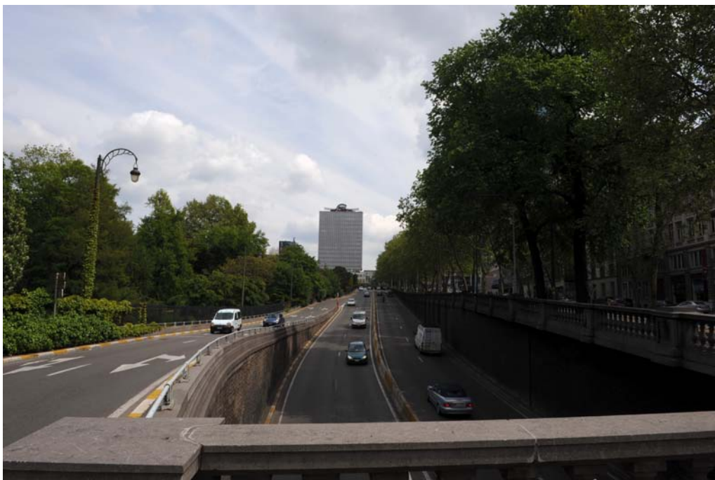
2 - Trémie du tunnel et tunnel Botanique 2 - Kruidtuintunnel
