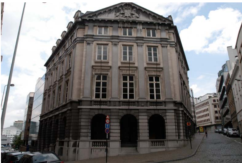
6 - Façade du bâtiment Dexia en face de la Cathédrale 6 - Gevel van het Dexia gebouw tegenover de Kathedraal
