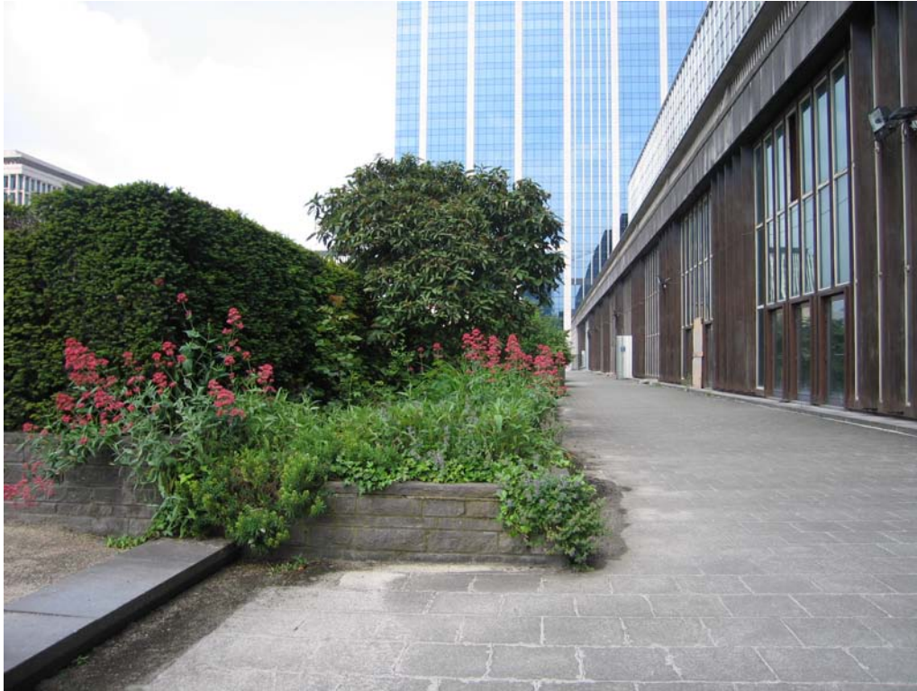
4 - Façade du bloc F en dessous de la Rue Rivoli 4 - Gevel van het gebouw F onder de Rivolistraat
