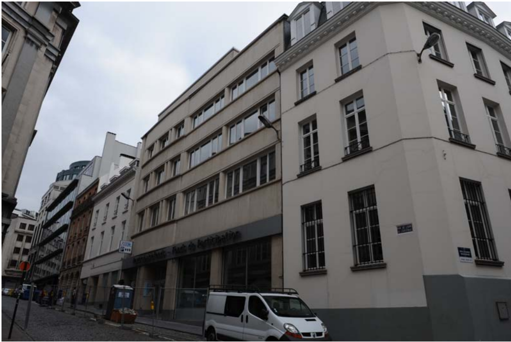
7 - Façades des immeubles dans la Rue de Ligne 7 - Gevels in de De Lignestraat
