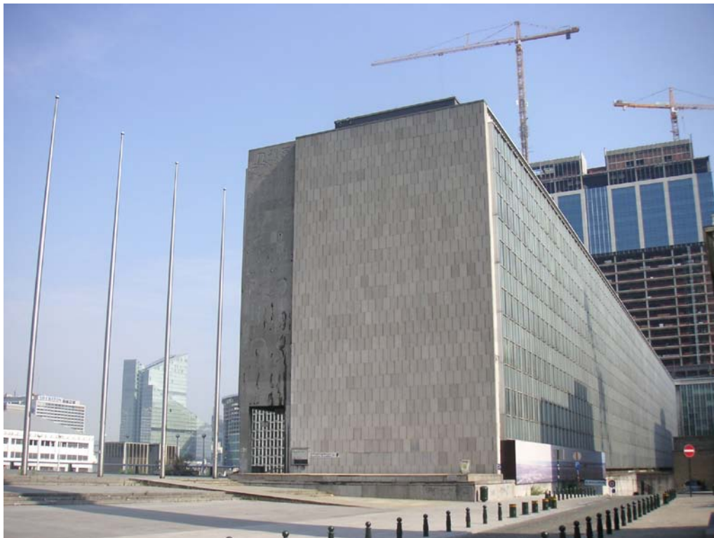
5 - Pignon aveugle du bloc F à l'entrée de l'Esplanade 5 - Blinde gevel ter hoogte van de ingang van de Esplanade
