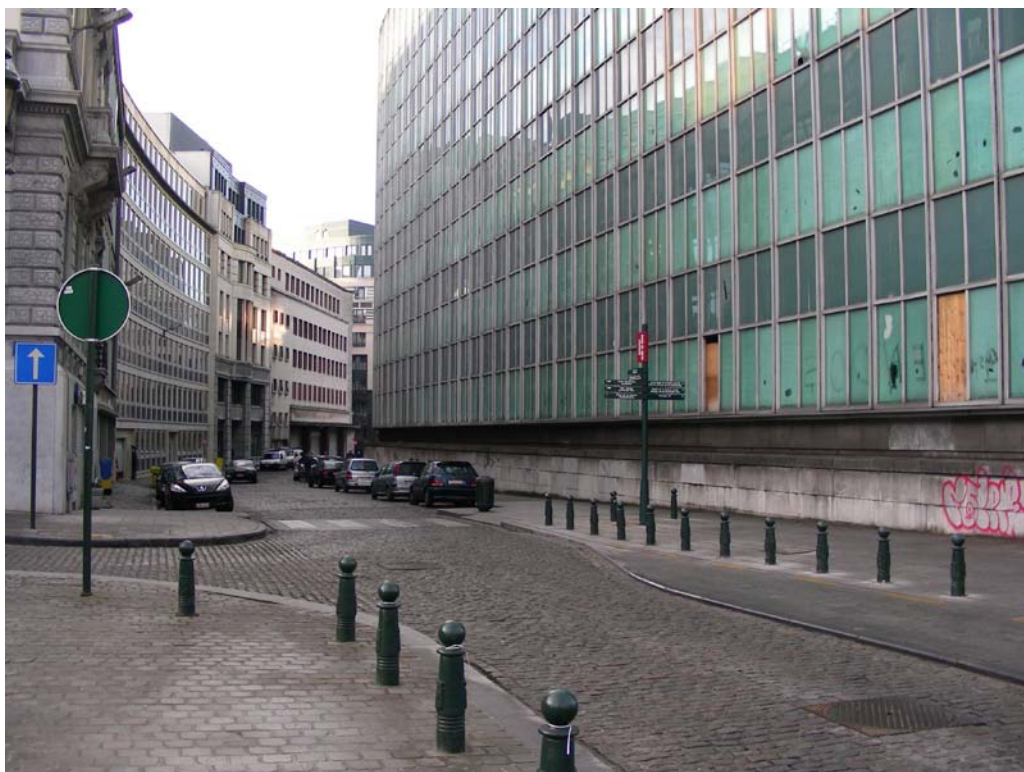
3 - Le bloc C du côté de la Rue de Ligne 3 - Het gebouw C in de De Lignestraat
