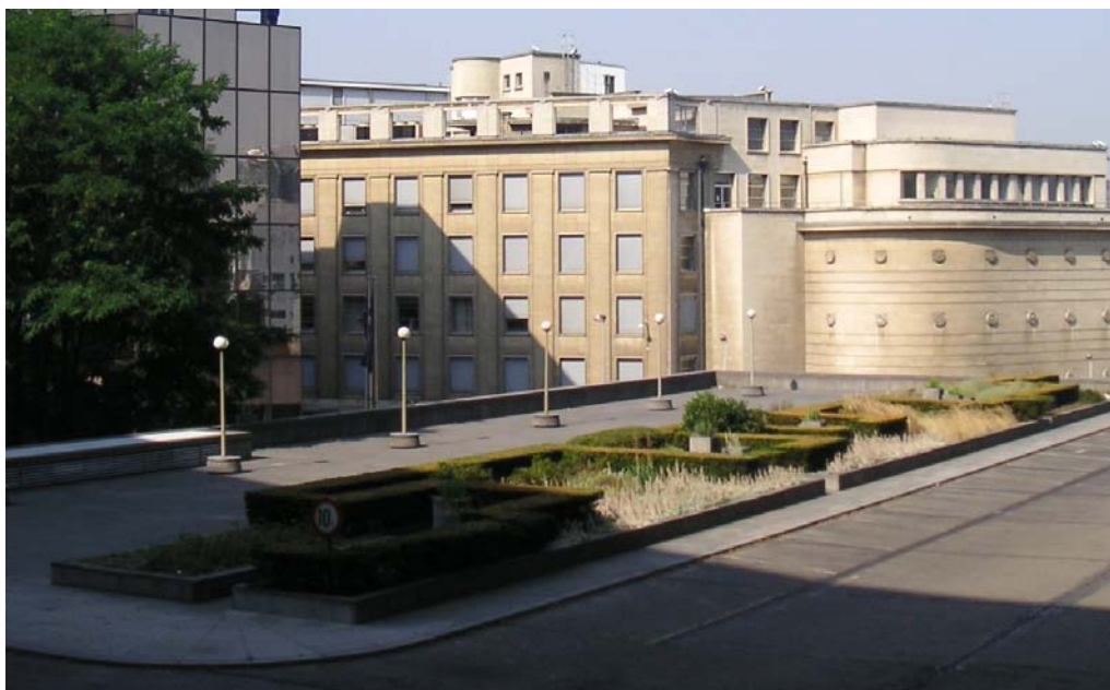
1 - Plantations sur le bloc H 1 - Begroeiing op het dak van gebouw H
